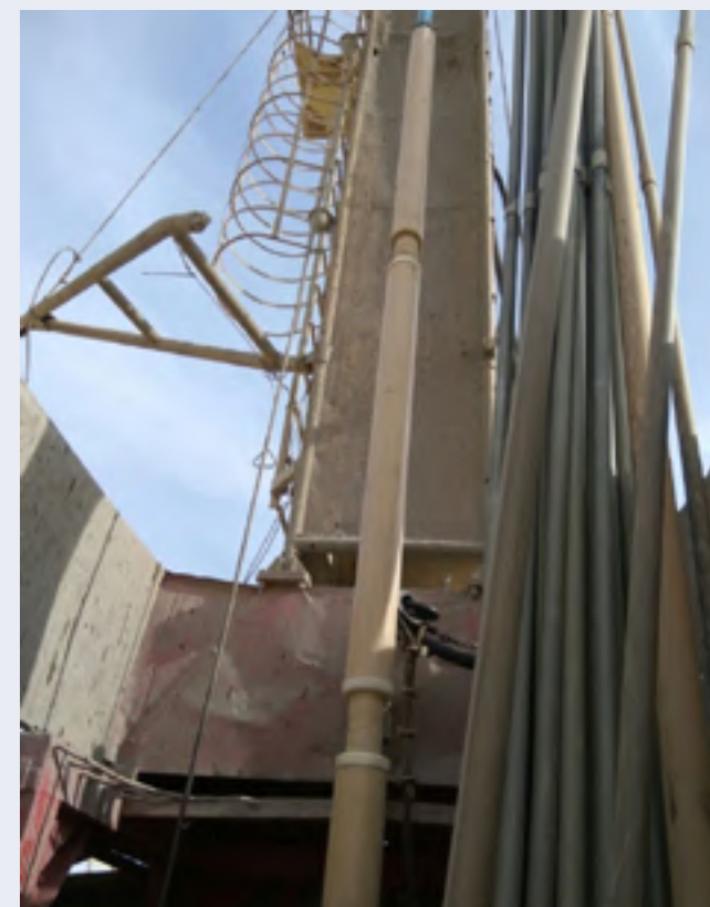
Рис.3. Спуск универсального щелевого фильтра Figure 3. Loading of universally applicable slotted filter
