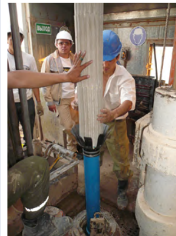
Рис.4. Спуск бентонитовой оболочки Figure 4. Loading of bentonitic jacket
