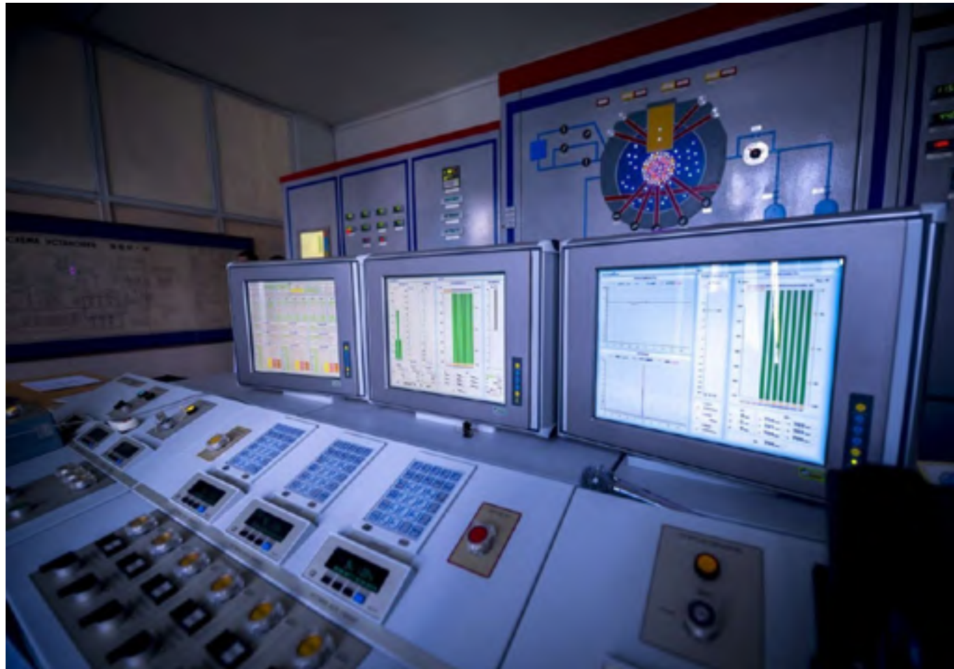
2-сурет. Реакторды басқарудың жаңғыртылған пульті
