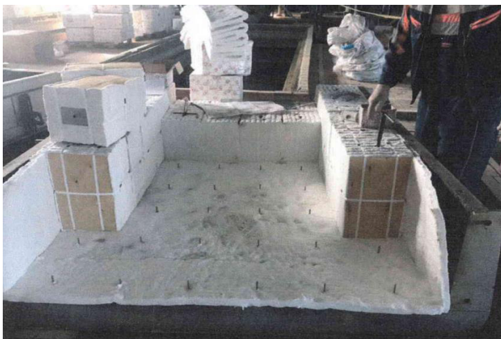
Рисунок 3. Заполнение крышки свода печи новым футеровочным материалом
