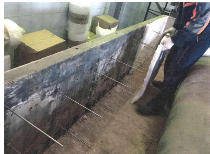
Рисунок 4. Монтаж новой футеровки боковых стен печи
