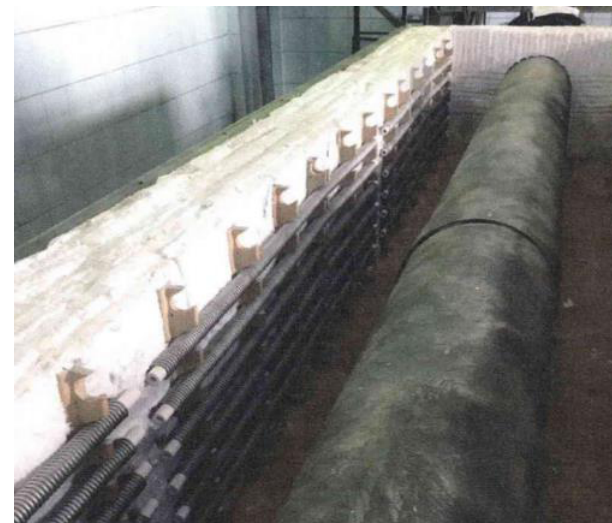
Рисунок 5. Монтаж нагревательных элементов
