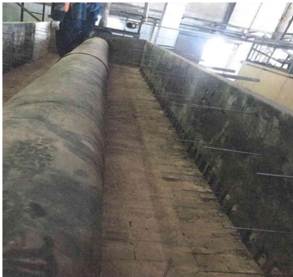
Рисунок 2. Подготовительные работы для монтажа новой футеровки печи, предварительно старая футеровка и нагревательные элементы были демонтированы
