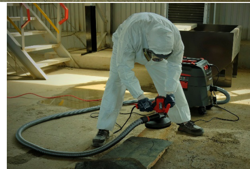
Рисунок 4. Дезактивация образцов с помощью шлифовальной машины
