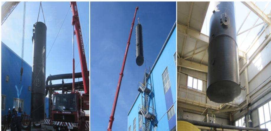
Рисунки 3. Общий вид монтажных работ сорбционно-напорных колонн СНК-3000 (WK-8000 PE RC-100) на руднике «Южный Инкай»
